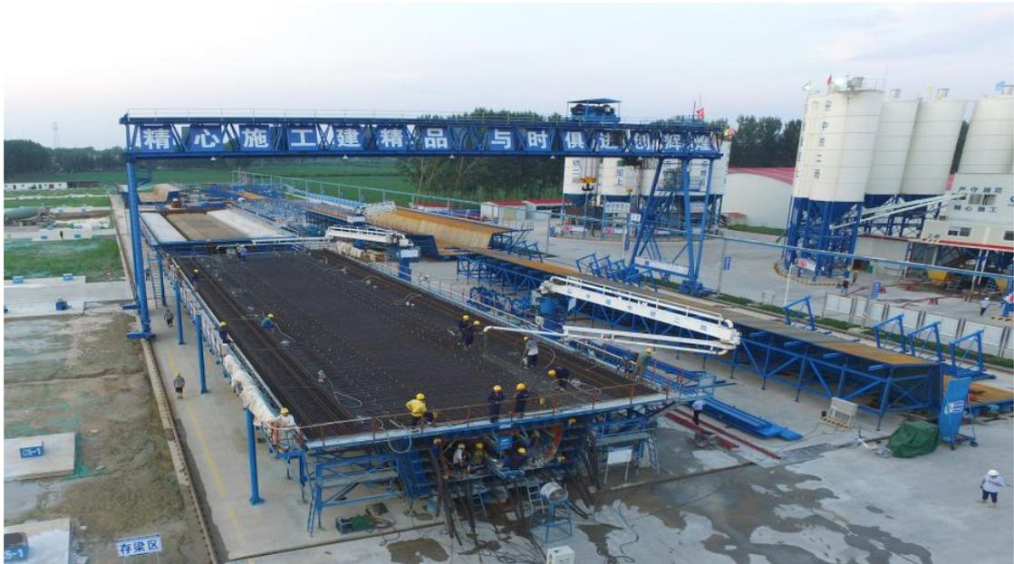
图 5.2.4-1 混凝土灌注
