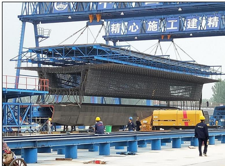
图 5.2.2-3 钢筋整体吊装
