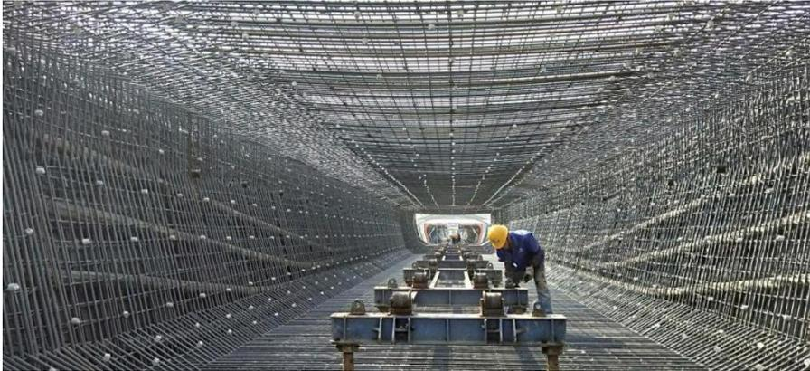
图 5. 2. 3-5 内模固定架安装及调整
