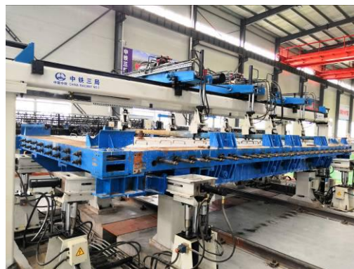
图 5.2.16-1 撑杆自动拆除
