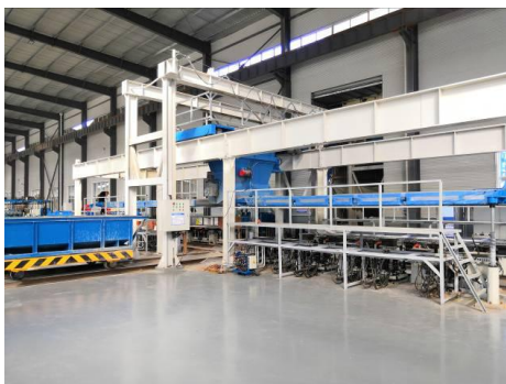
图 5.2.12-1 混凝土运输及布料行走架
