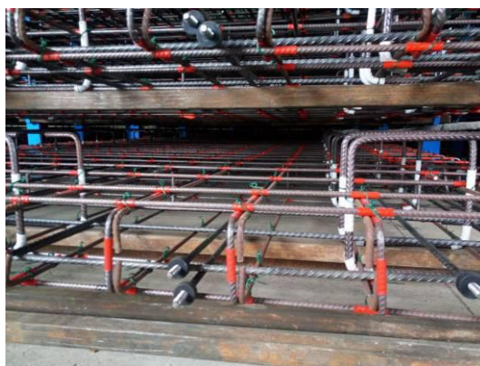
图 5.2.2-2 钢筋交叉处绝缘处理
