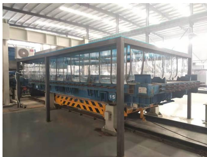
图 5.2.11-1 模板温度自动检测控制设备
