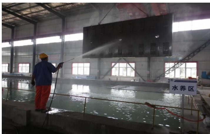
图 5.2.23-1 高压水枪清理轨道板
