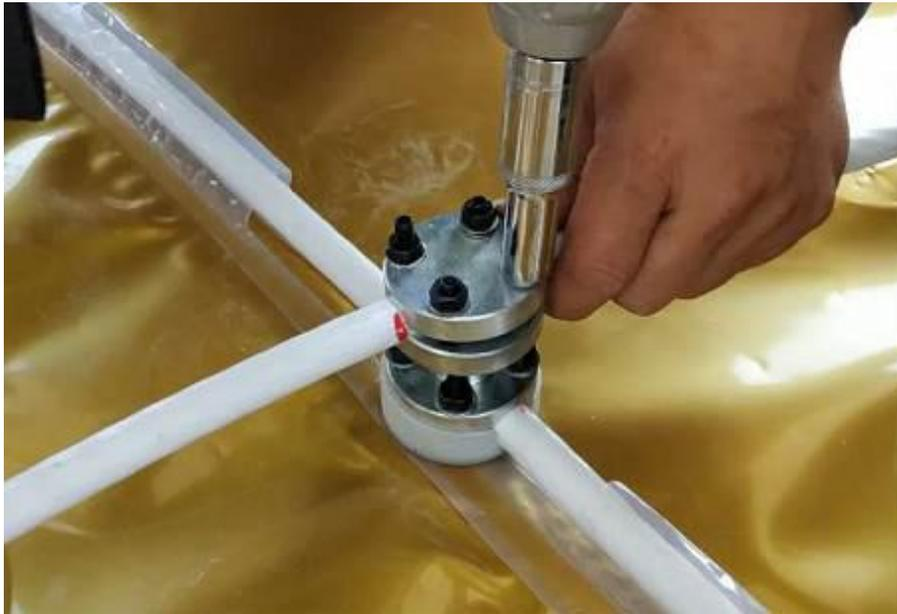
图 5.2.8-4 根据竖向索索夹标定位置，安装万向索夹
