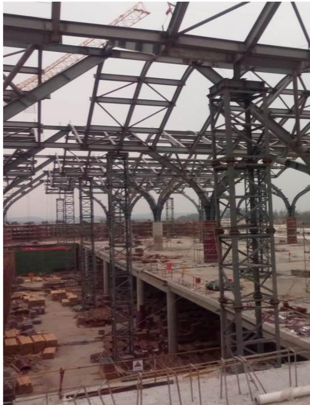
图 5.2.3-3 格构式临时支撑体系实例
