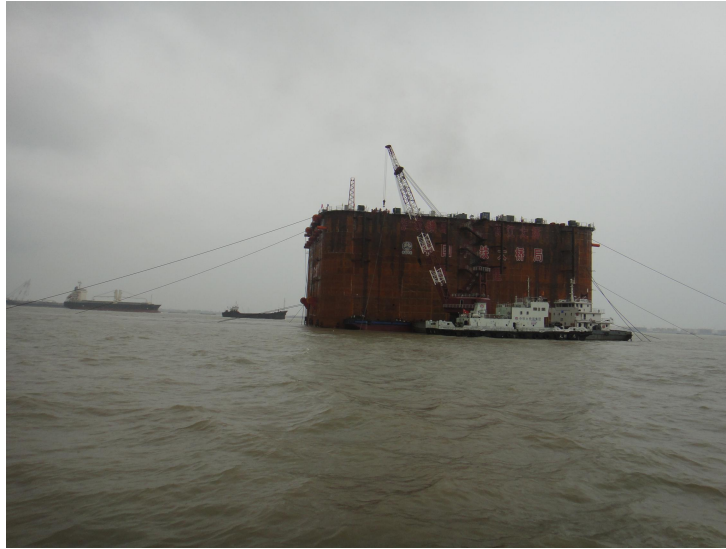
图 15 边锚拉缆挂设
