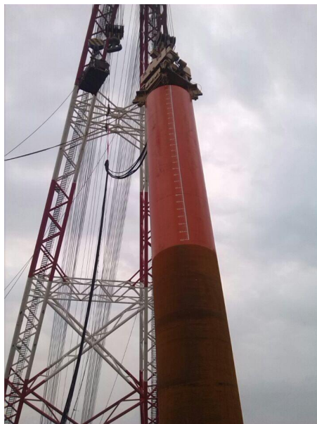
图 7 大直径钢桩插打
