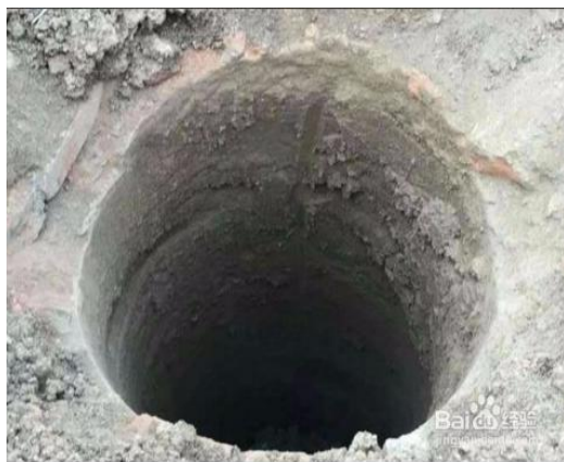
螺旋钻机成孔后
