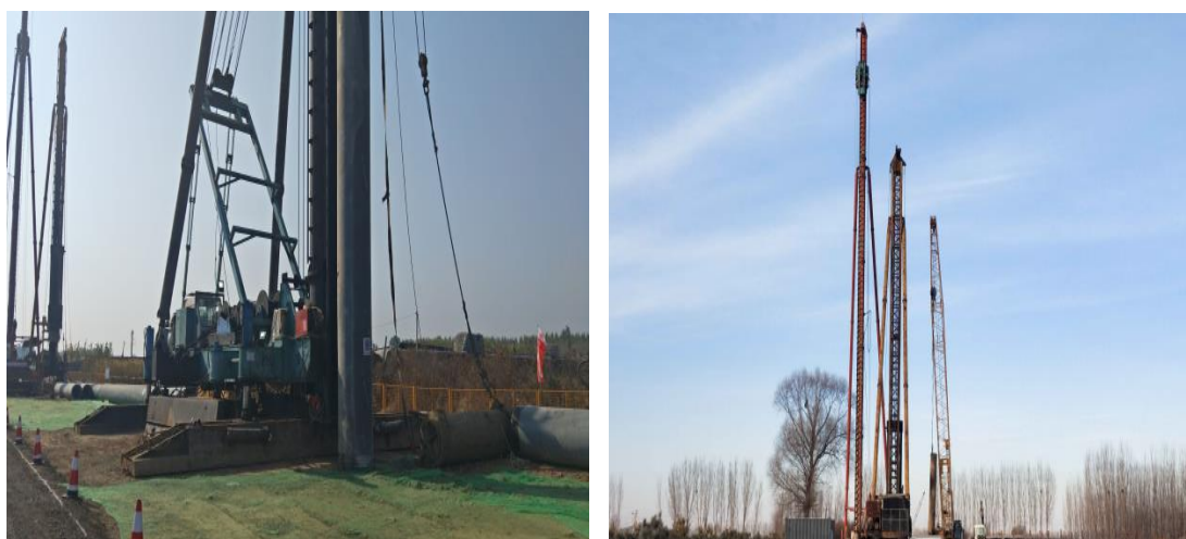
图 11-1 京雄城际铁路五标预制桩基础实体工程施工
