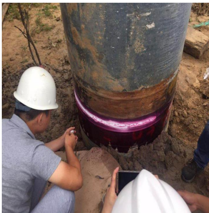
图 5-5 预制桩焊接检测
