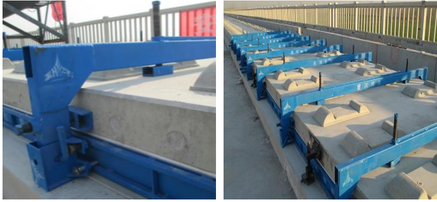
图 5.2.4-2 定型的轨道板铺设精度保持装置
