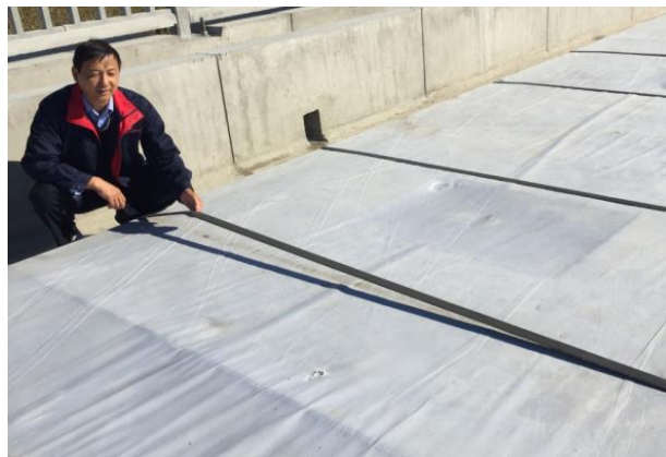
图 5.2.1-6 土工布临时压紧装置
