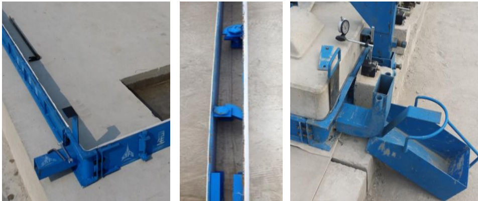
图 5.2.4-3 自密实混凝土灌注组合模板实物
