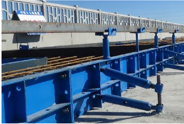
图 5.2.1-2 底座纵向模板及收面机走行轨道
