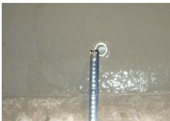
图 5.2.1-1 自制底座预埋套筒
