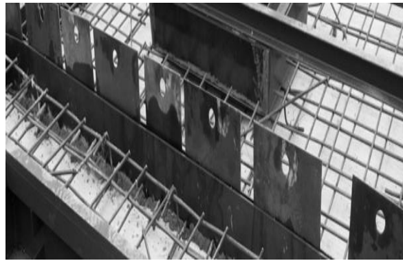
图 5.2.1-3 底座横向模板
