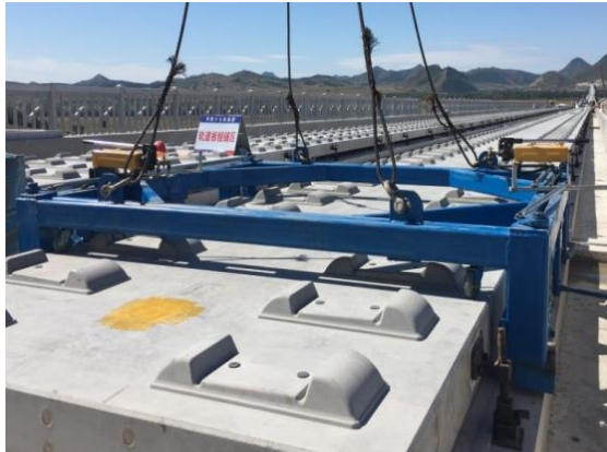
图 5.2.4-1 高速铁路轨道板铺设精度快速调整装置
