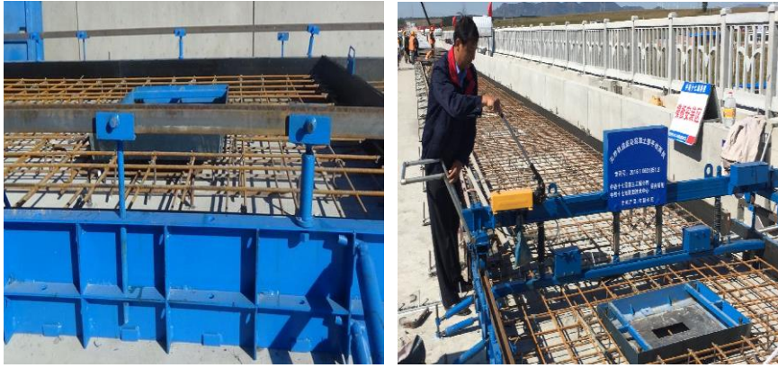
图 5.2.1-5 设备走行轨道及混凝土整平收面机
