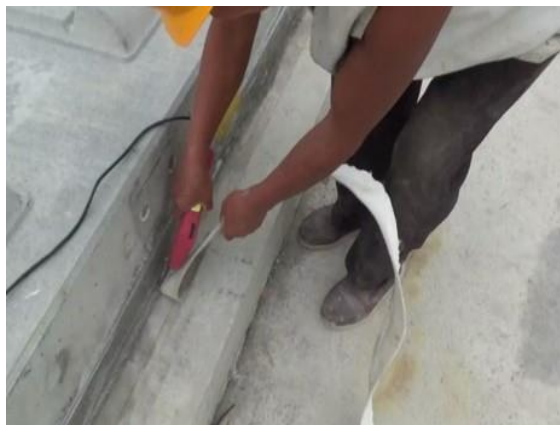
图 5.2.8 轨道板边缘外露土工布裁剪
